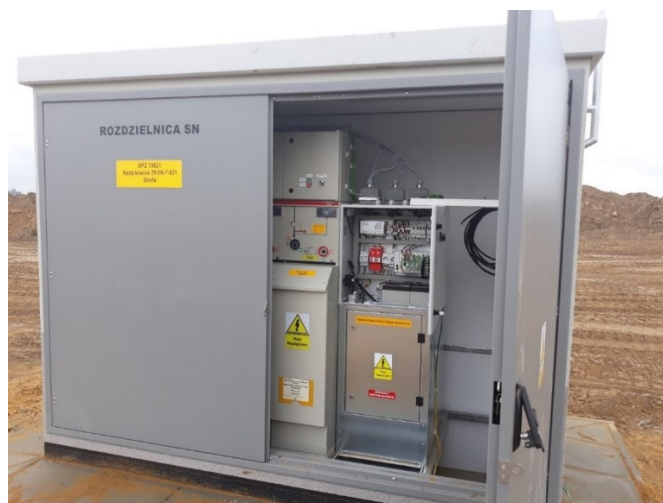
Fot. 1. Złącze kablowe średniego napięcia z elementami multipolowej telemechaniki i układem elektroenergetycznej automatyki zabezpieczeniowej.
