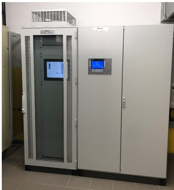
Rys. 4. Szafa regulatora napięcia wzbudzenia rezerwowego
