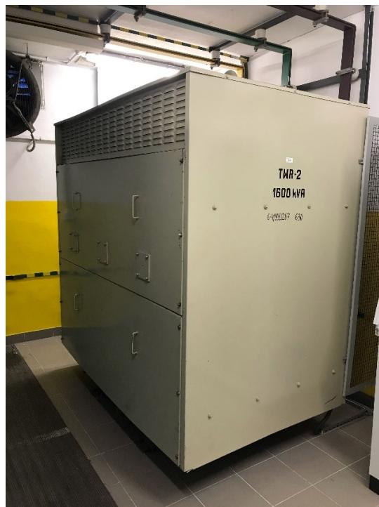
Rys. 3. Transformator wzbudzenia rezerwowego TWR-2
