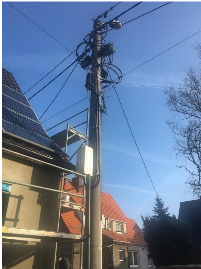
Rys. 10. Miejsce przyłączenia OZE przykład miejsca montażu szafki
