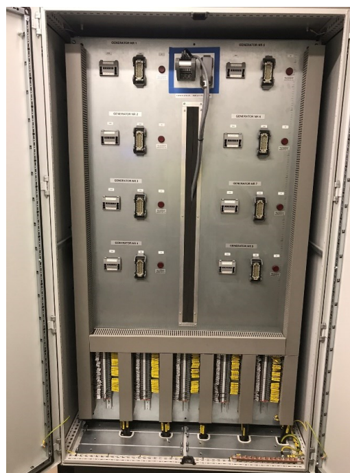
Rys. 6. Gniazda pomiarowe i wtyki testowe w szafie wzbudzenia rezerwowego
